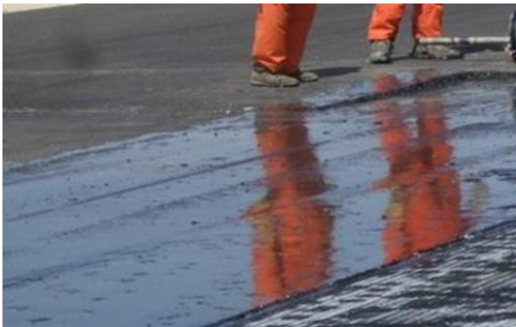
6.1-4 attēls. Spoguļa efekts svaigi izsmidzinātā saistes slānī un melni nospiedumi uz ģeokompozīta pēc pareizas ieklāšanas uz pareizi izsmidzinātās saistvielas
