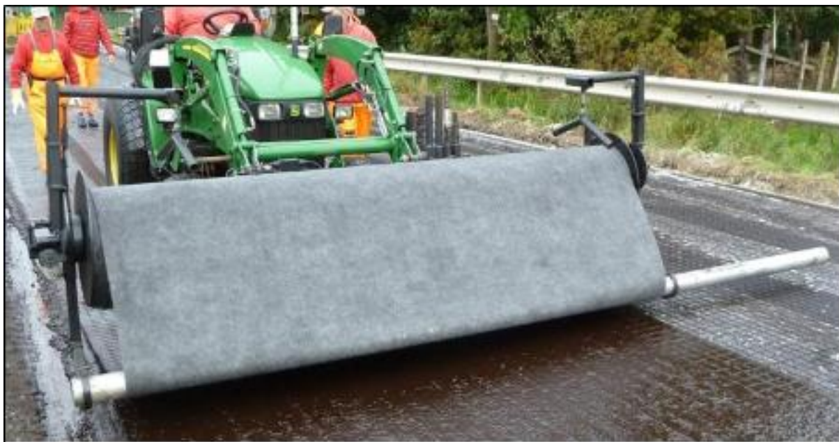
6.1-1 attēls. Ģeokompozīta mehāniska ieklāšana
