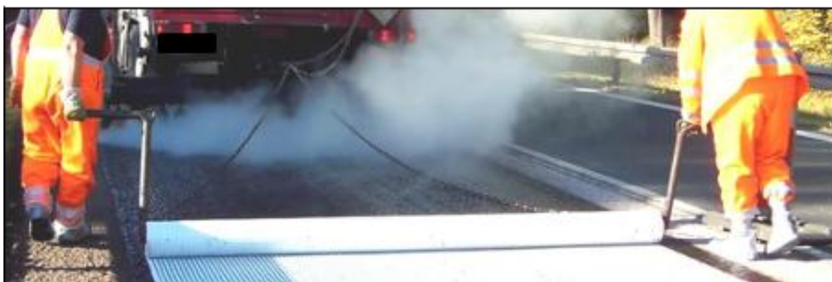
6.1-2 attēls. Ģeokompozīta manuāla ieklāšana
