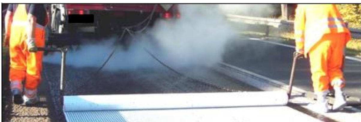
6.1-2 attēls. Ģeokompozīta manuāla ieklāšana
