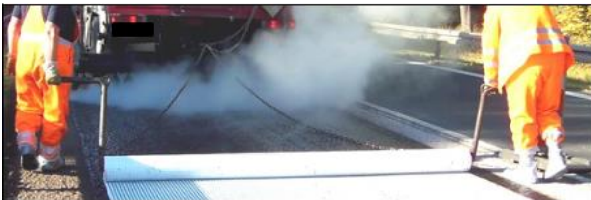
6.1-2 attēls. Ģeokompozīta manuāla ieklāšana
