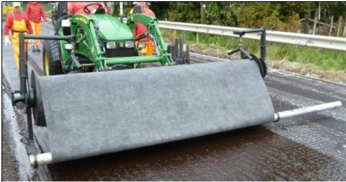
6.1-1 attēls. Ģeokompozīta mehāniska ieklāšana
