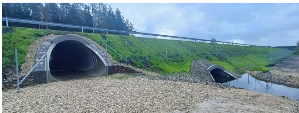
Slēpotāju tunelis (14. km) un Osvalda kanāla caurteka (14. km)
