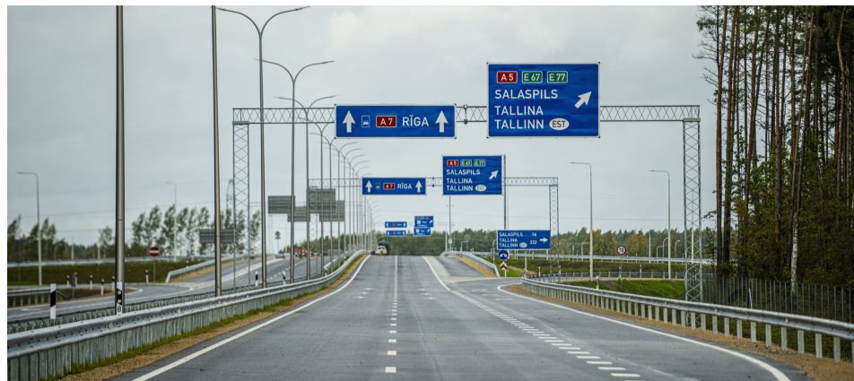
Pārvads pār Rīgas apvedceļu (Salaspils–Babīte) (19. km)
