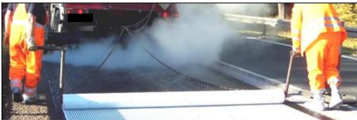
6.1-2 attēls. Ģeokompozīta manuāla ieklāšana
