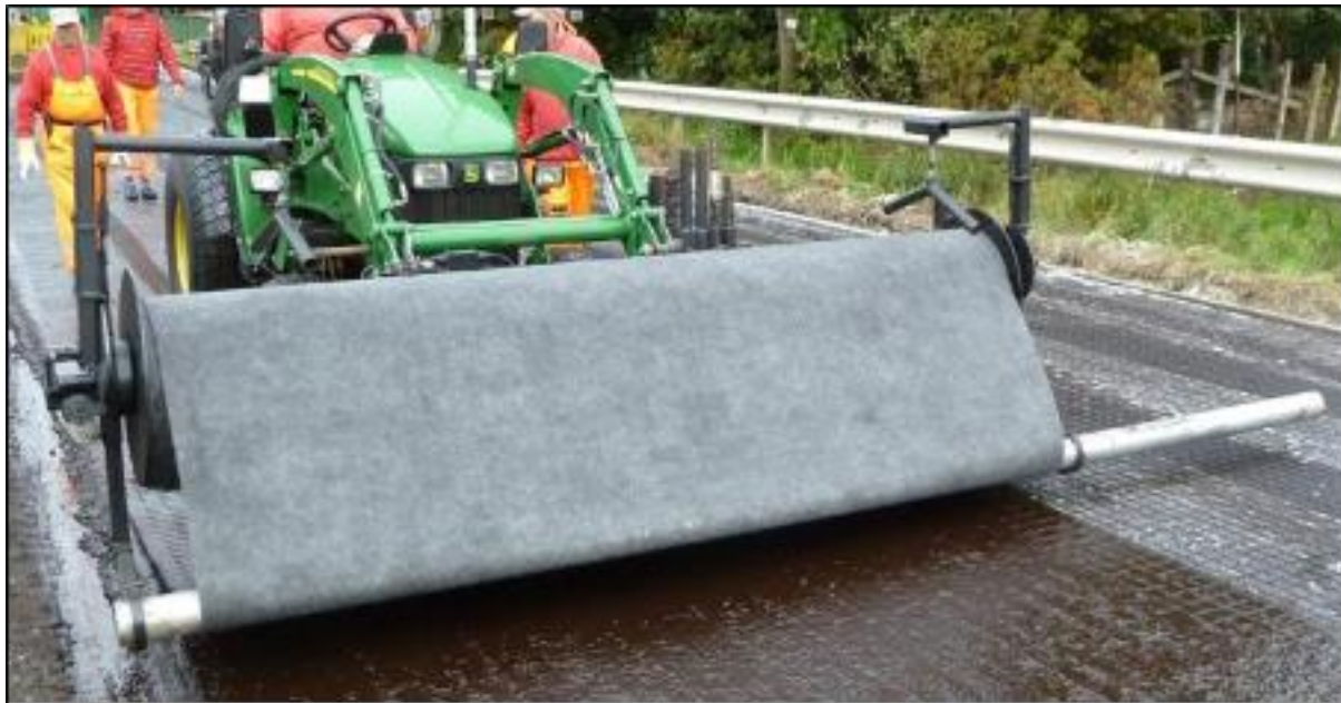
6.1-1 attēls. Ģeokompozīta mehāniska ieklāšana
