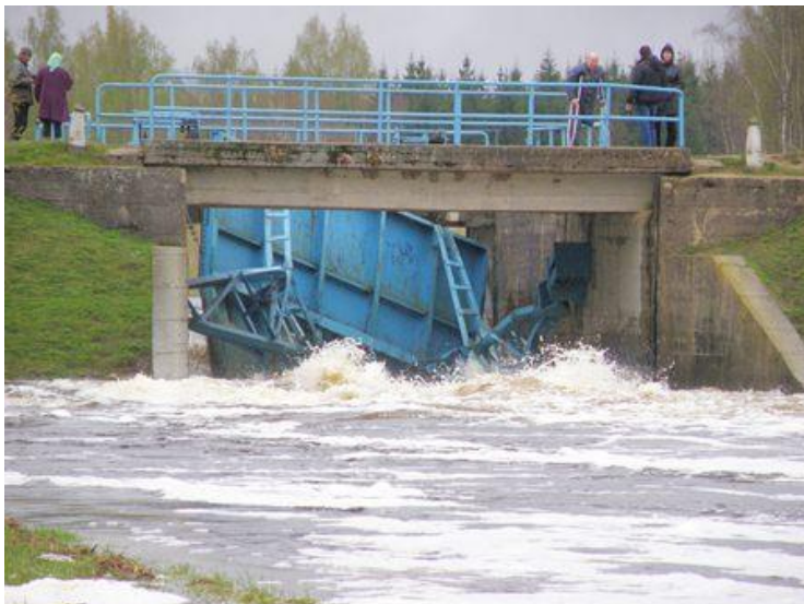
Kalnagala hidromezgls pirms un pēc rekonstrukcijas
