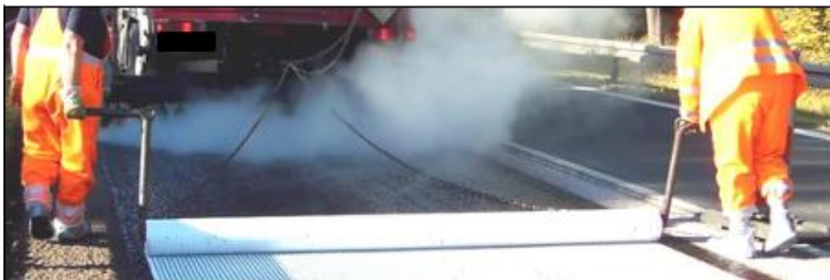
6.1-2 attēls. Ģeokompozīta manuāla ieklāšana
