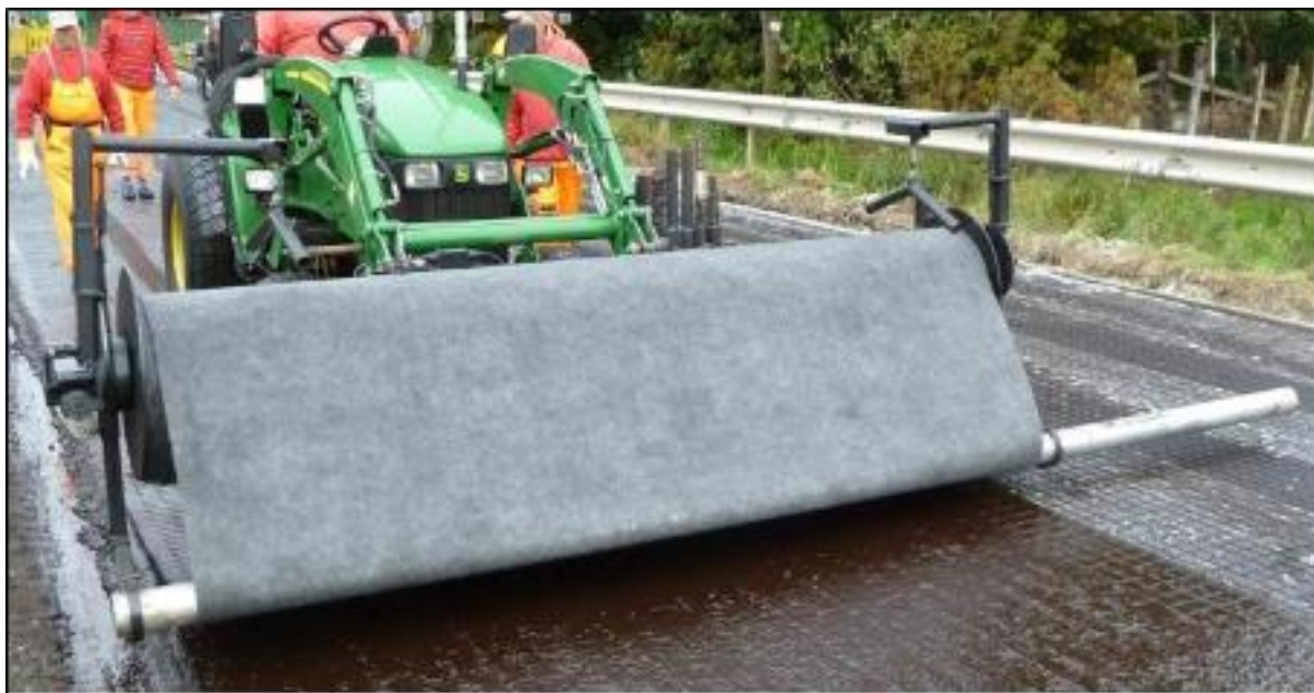
6.1-1 attēls. Ģeokompozīta mehāniska ieklāšana
