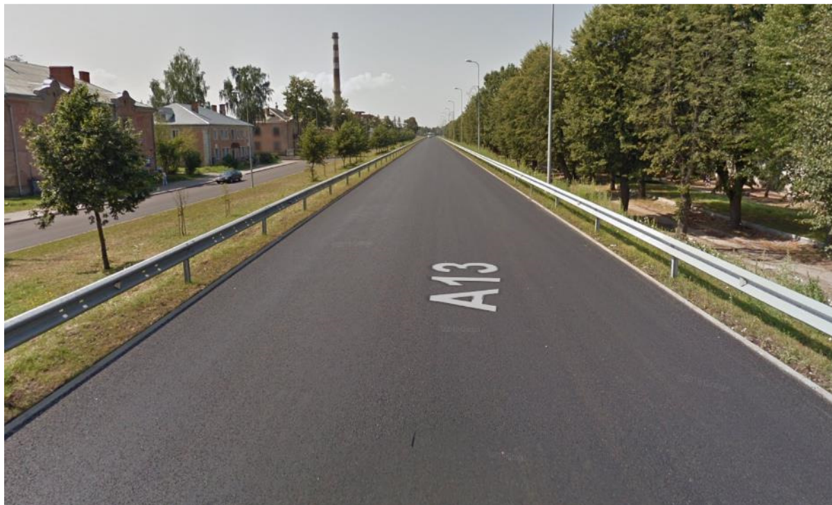
3-7.35. attēls. Izbūvēta asfalta virskārta 2014. gads [62]
