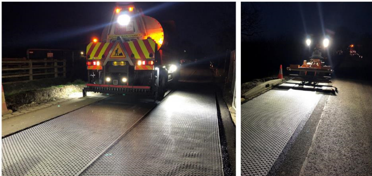
3-7.19. Seguma atjaunošanas izbūves process [48]
