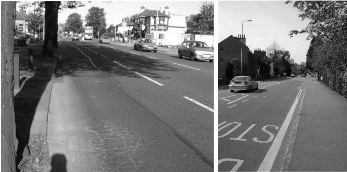
3-7.30. attēls Noguruma plaisas Abingdonas ceļā pirms rekonstrukcijas (pa kreisi) un Abingdonas ceļš 2016. gadā (pa labi) [60]
