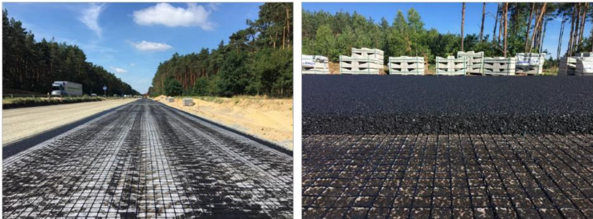
3-7.13. Ģeokompozīta iebūves process 2018. gadā [48]
