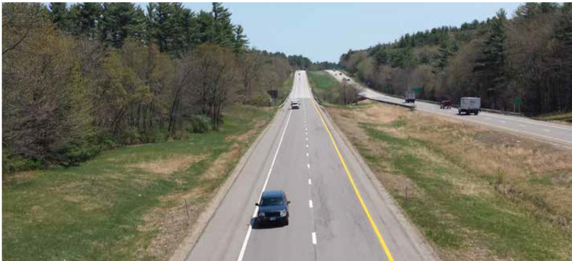
3-7.27. attēls. Braukšanas virzienā labā josla pastiprināta ar ģeorežģi bez plaisām, kreisā josla ar plaisām, 2014. gadā [61]
