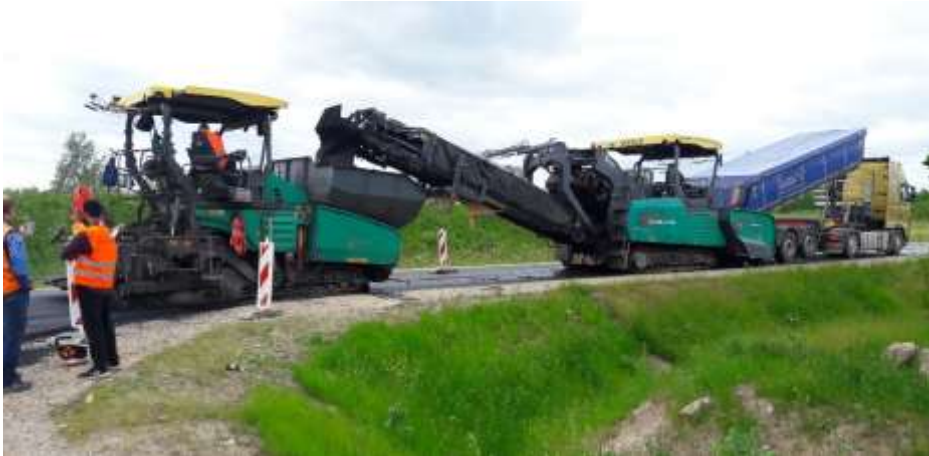
Attēls 17. HMA-R160(A) un HMA-R160(B) ieklāšana izmantojot antiseģregācijas iekārtu.
