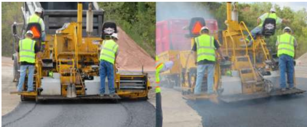
Attēls 9. Izgarojumi ieklāšanas laikā.
