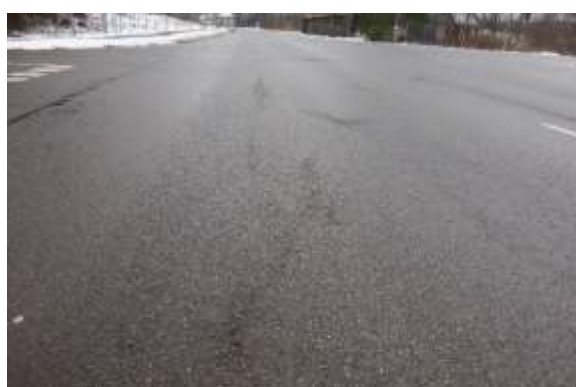
Attēls 28. Temperatūras segregācijas radītu bojājumu piemērs.
