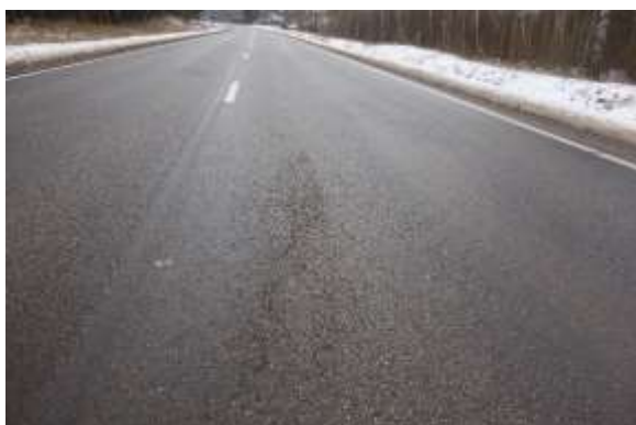
Attēls 28. Temperatūras segregācijas radītu bojājumu piemērs.
