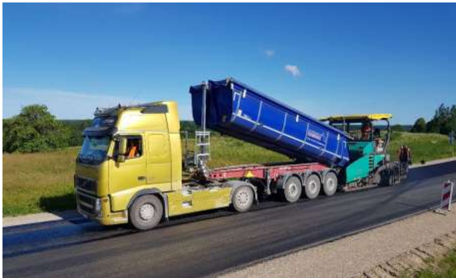
Attēls 18. WMA-R160 un WMA-R140 ieklāšana bez antiseģregācijas iekārtas.
