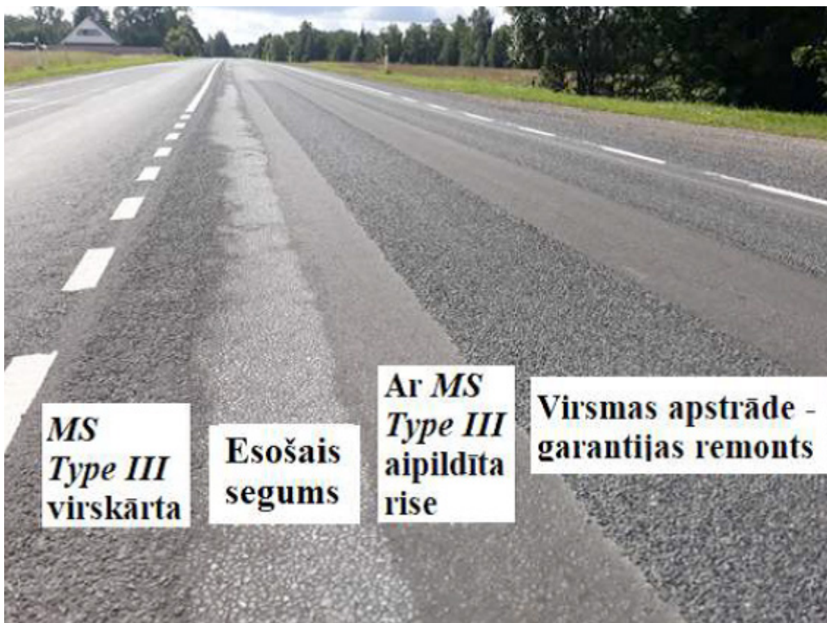
52. att. MS seguma stāvoklis pēc viena ekspluatācijas gada
