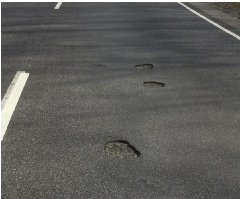
17. att. Slurry seal atslāņošanās ( https://slideplayer.com )
