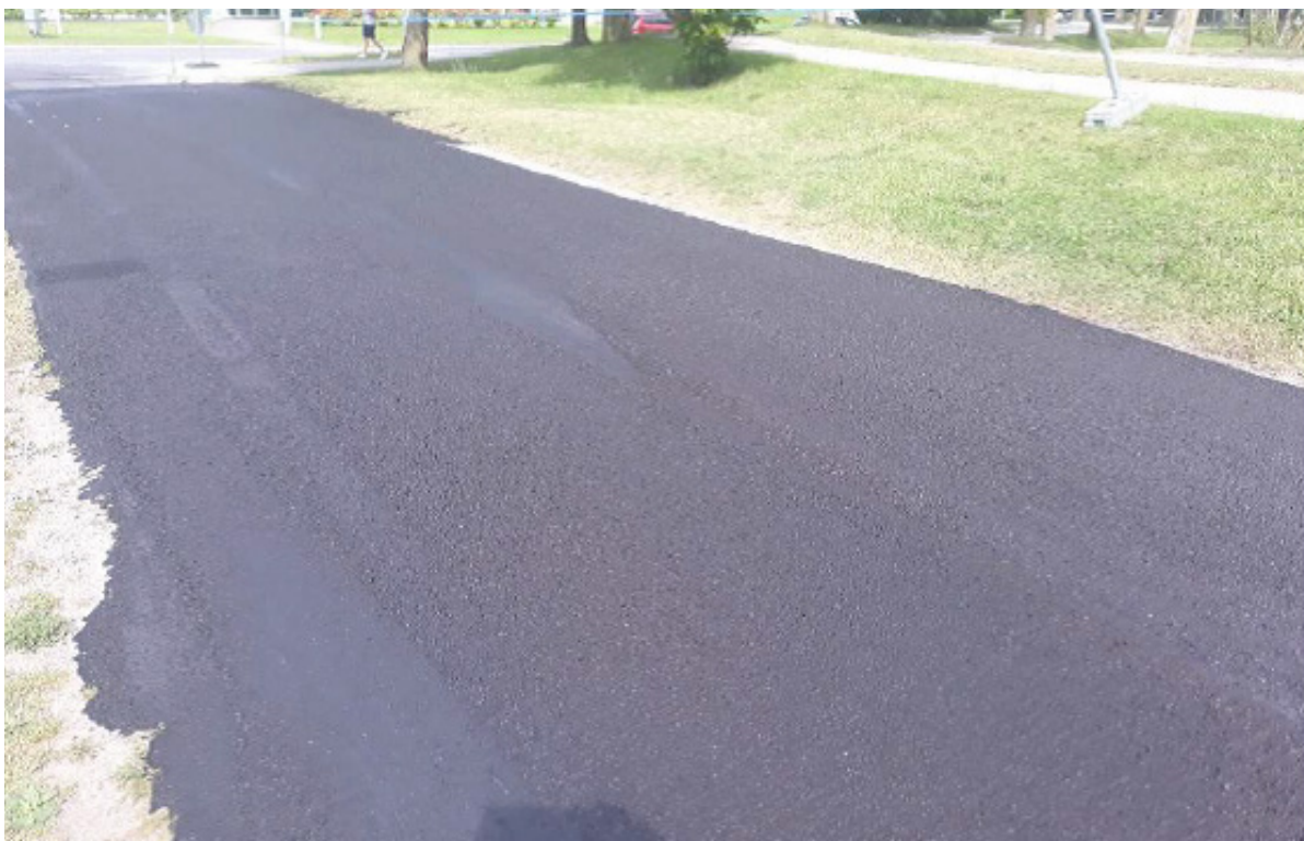
43. att. Ieklātā MS izlīdzinošā kārtā
