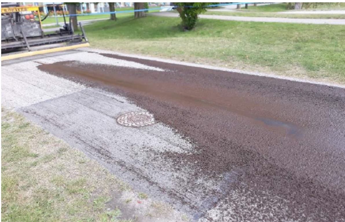
45. att. MS uzklāšana virs akas lūkas
