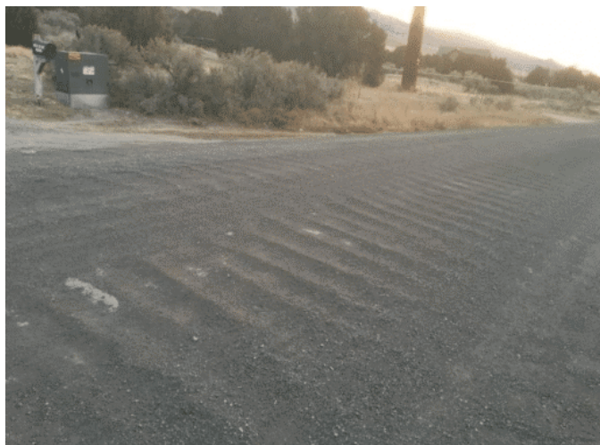
21. att. Šķērsvīļņošanās jeb rievu veidošanās ( http://www.pavemanpro.com )
