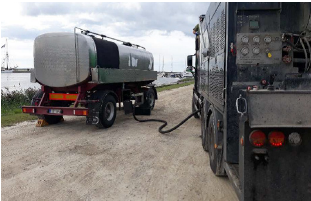
32. att. MS mašīnas piepildīšana ar bitumena emulsiju
