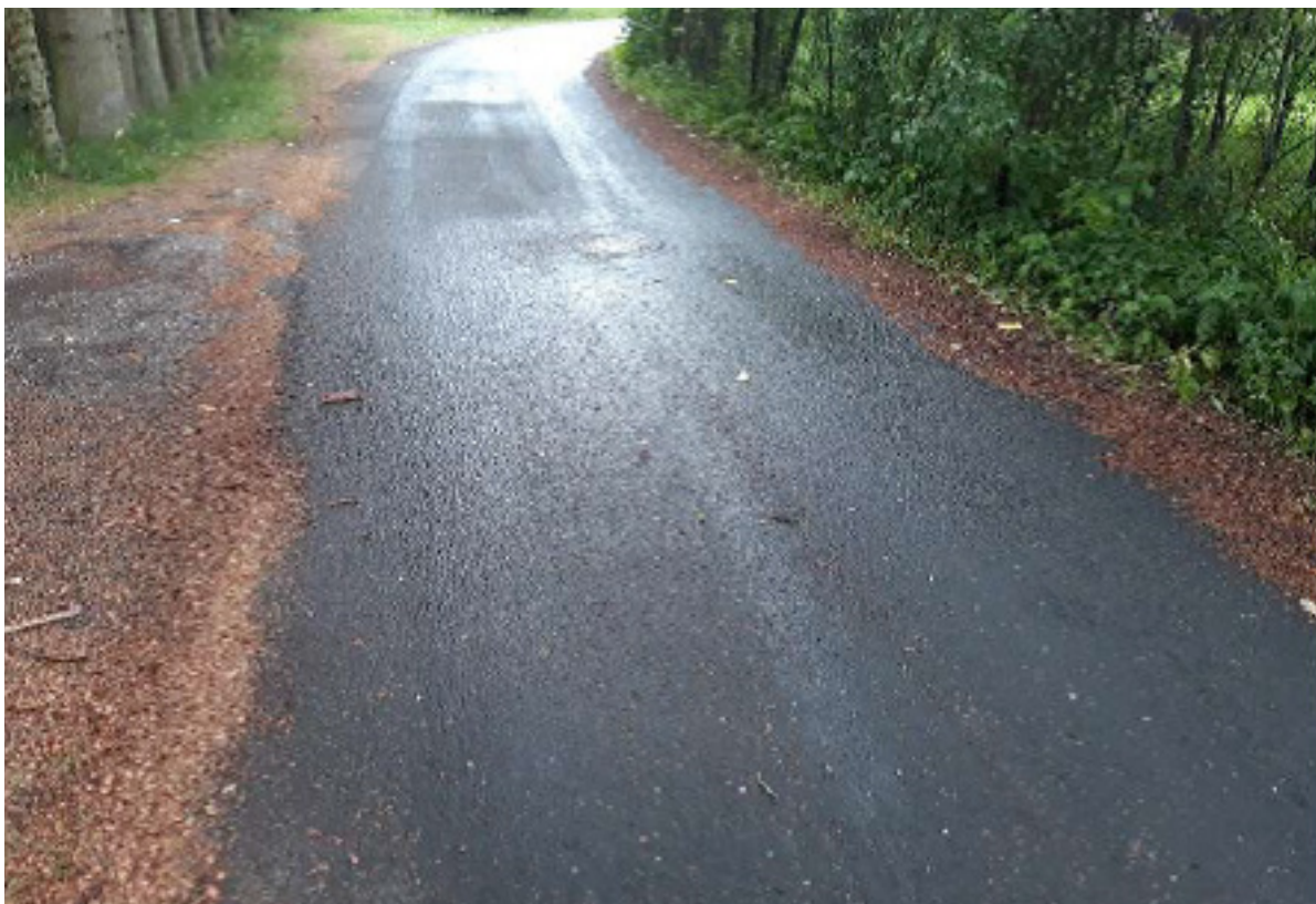
50. att. MS seguma stāvoklis pēc viena ekspluatācijas gada
