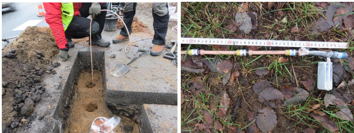
14. attēls. Termistoru kabeļa ievietošana urbumā (pa labi) un kabeļa galā pieliktais atsvars.
