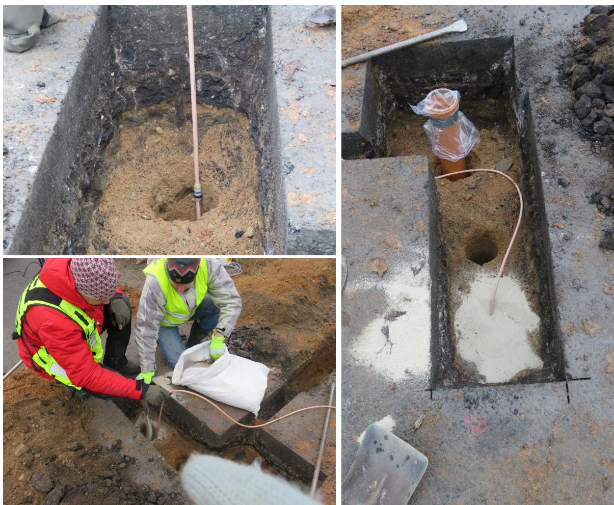
15. attēls. Termistoru kabeļa augšējais sensors atrodas 0,38 cm no asfalta virsmas (pa kreisi augšējais att.). Urbuma aizbēršana ar frakcionētu smilti (pa kreisi apakšējais att.). Aizbērts urbums un nostiprinātais kabelis.
