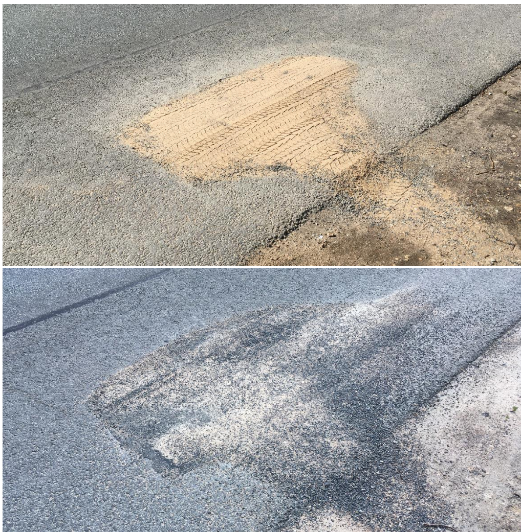
13. attēls. Monitoringa vieta tūlīt pēc izolācijas (augšējais att.), un 1 mēnesi pēc izolācijas (apakšējais att.).
