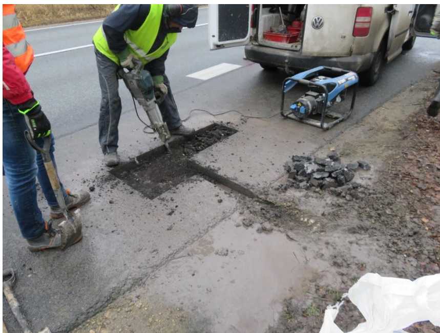
6. attēls. Asfalta kārtas demontāža un kabeļu novada izveide.
