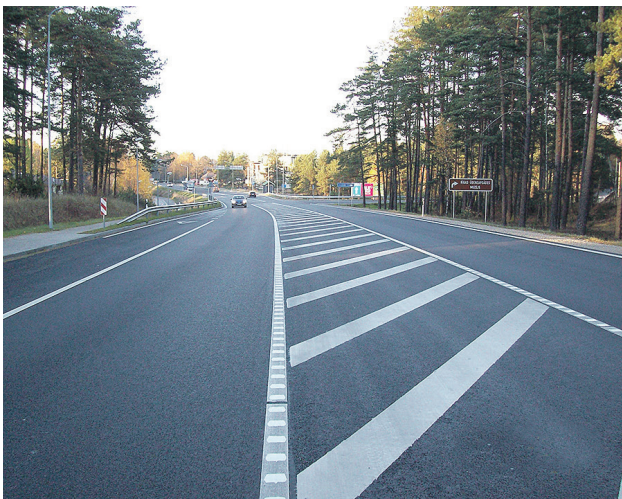
2016. gada oktobrī izveidotās ribjoslas Baltezerā uz Tallinas šosejas (A1)
