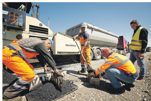
Asfaltbetona maisījuma paraugus testēšanai ar kvartotāju sadala četrās vienādās daļās
