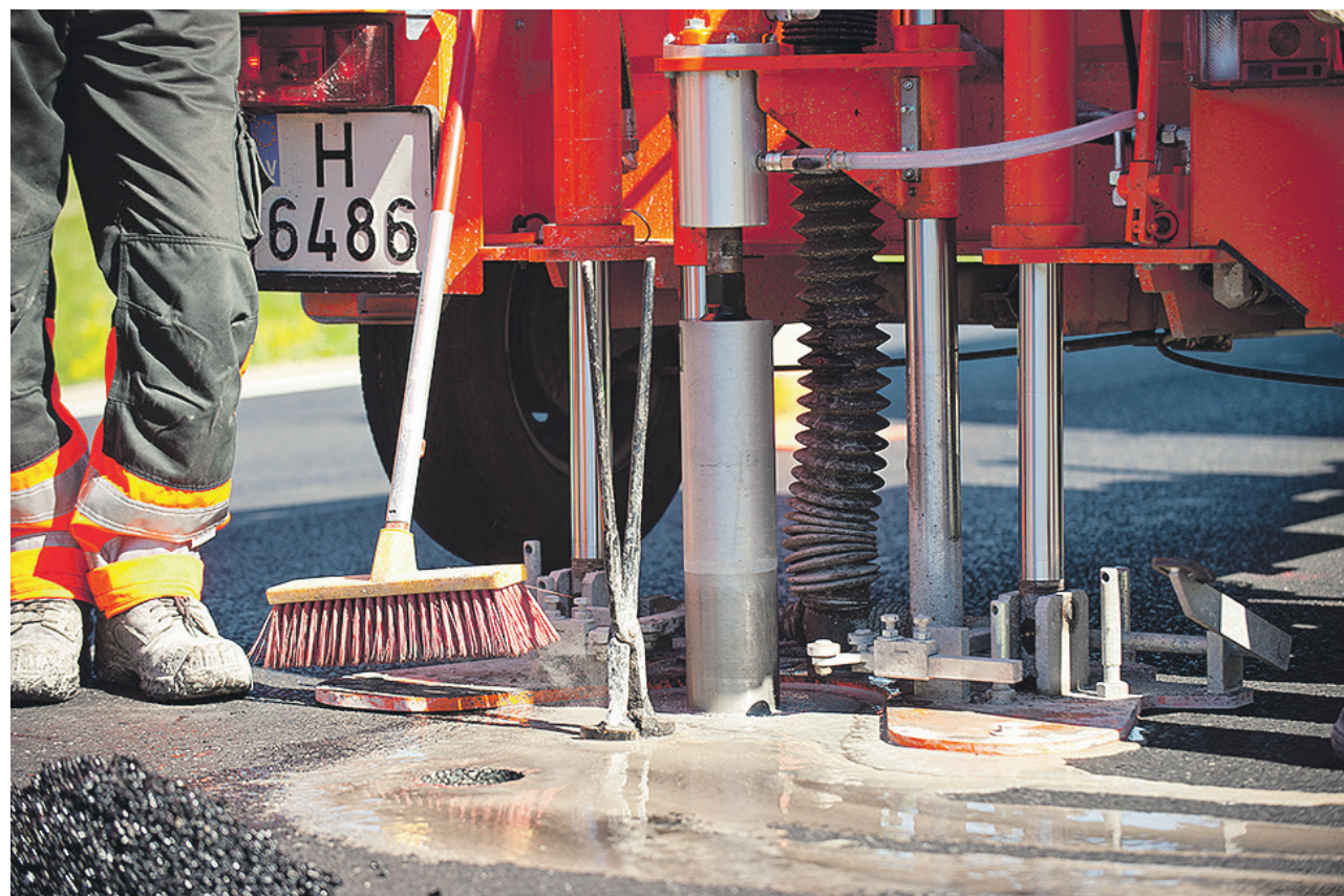
Ar asfaltbetona paraugu urbšanas iekārtu tiek noņemti paraugi, aizpildītas urbumu vietas.
