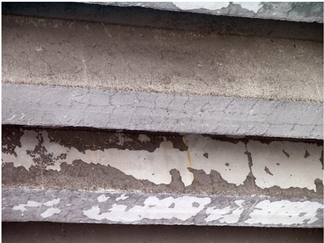
1.5.att. Sārnu-pildvielu reakcijas izraisīts plaisu tīkls uz A9 un A5 krustojumā esošā ceļa pārvada sijām.
