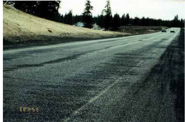
2.19. att. Virsmas izdrupumi radušies no sniega tīrīšanas [16]
