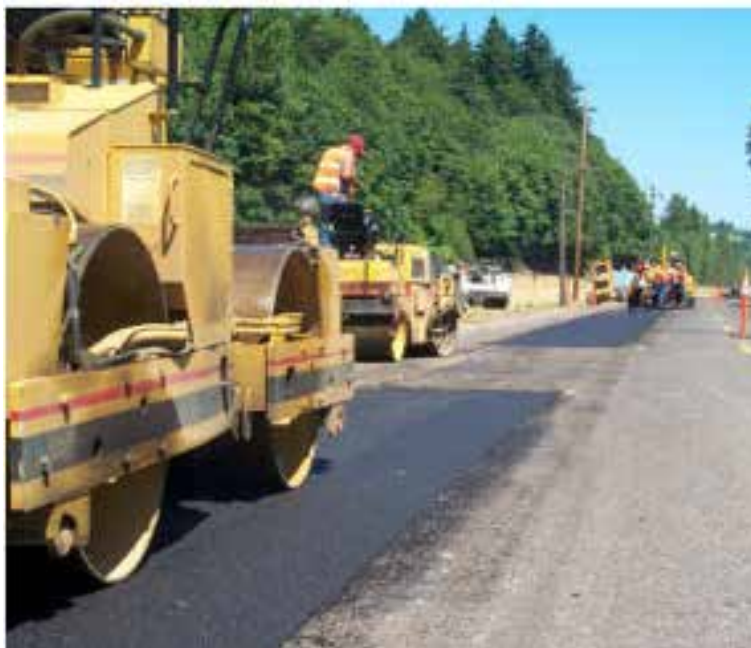
2.40. att. Bojāto posmu labošana pirms BBTM dilumkārtas ieklāšanas [31]
