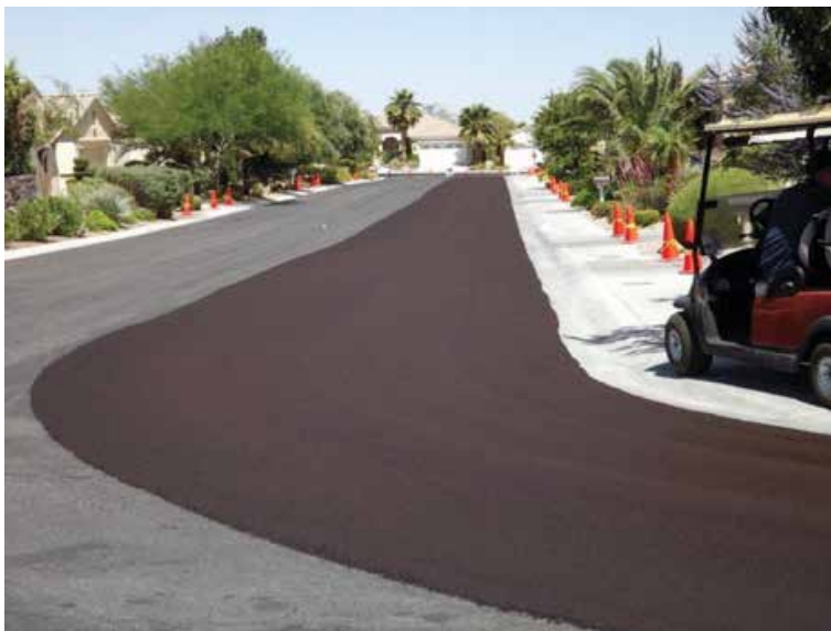
2.30. att. Slurry seal [24]
