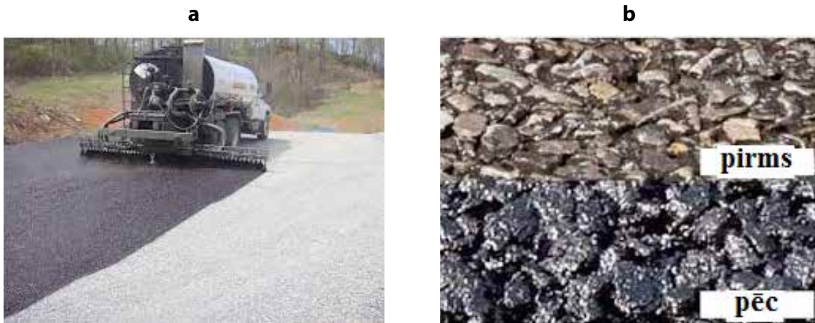
2.21.att. Ar bitumena emulsiju apstrādāts segums. [18] a) bitumena emulsijas izsmidzināšana; b) seguma virsma pirms un pēc apstrādes
