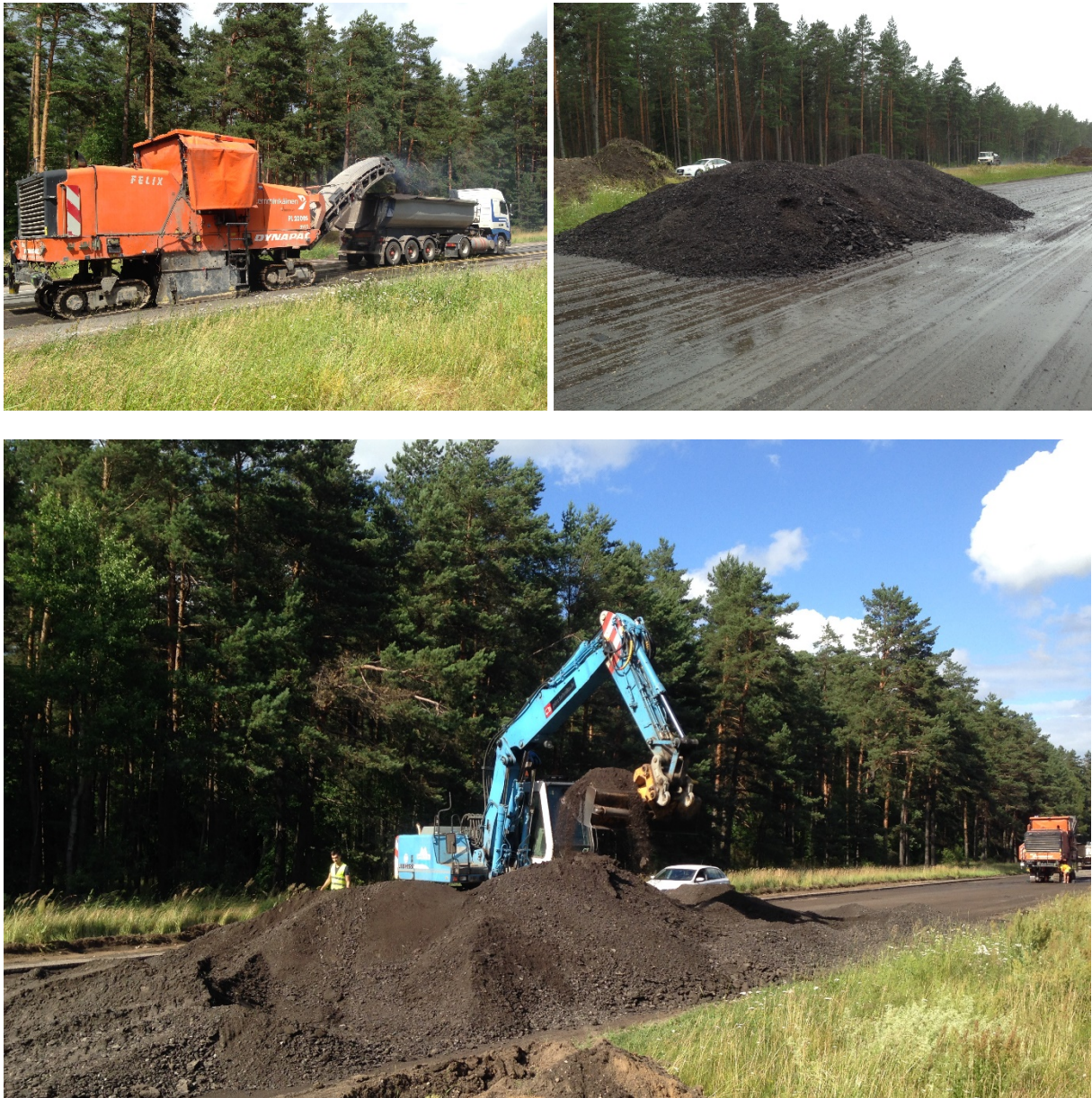
Ilustrācija 17. Asfalta frēzēšana, krautne pirms pārmaisīšanas un maisīšanas operācija (paraugi tika noņemti pēc katras operācijas)
