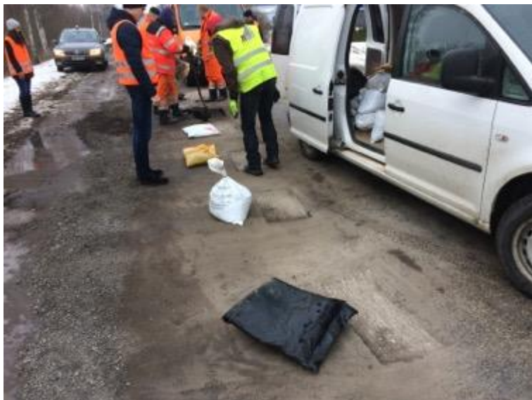
7-5 . attēls. Sagatavošanās bedrīšu aizpildīšanai
