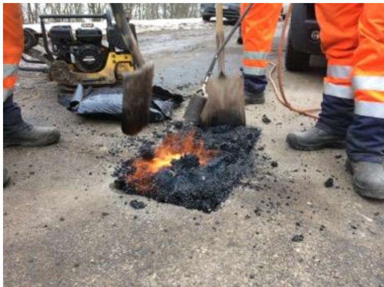
7-8 . attēls. Aukstā bituminētā maisījuma karsēšana
