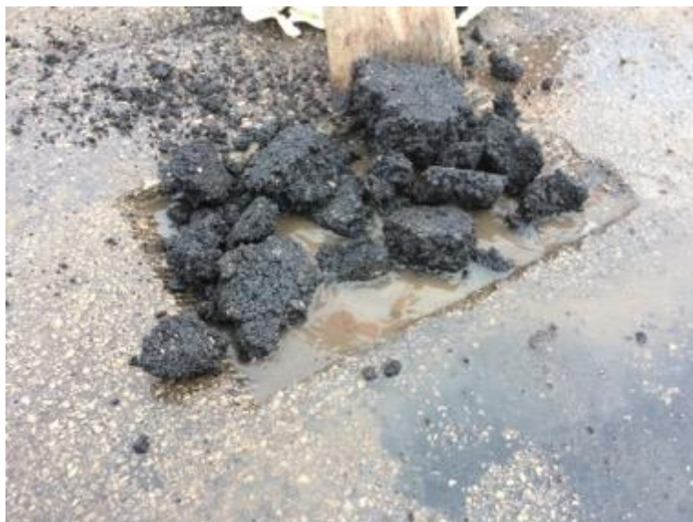
7-13 . attēls. Aukstā bituminētā maisījuma iestrāde ar ūdeni pielietā bedrītē
