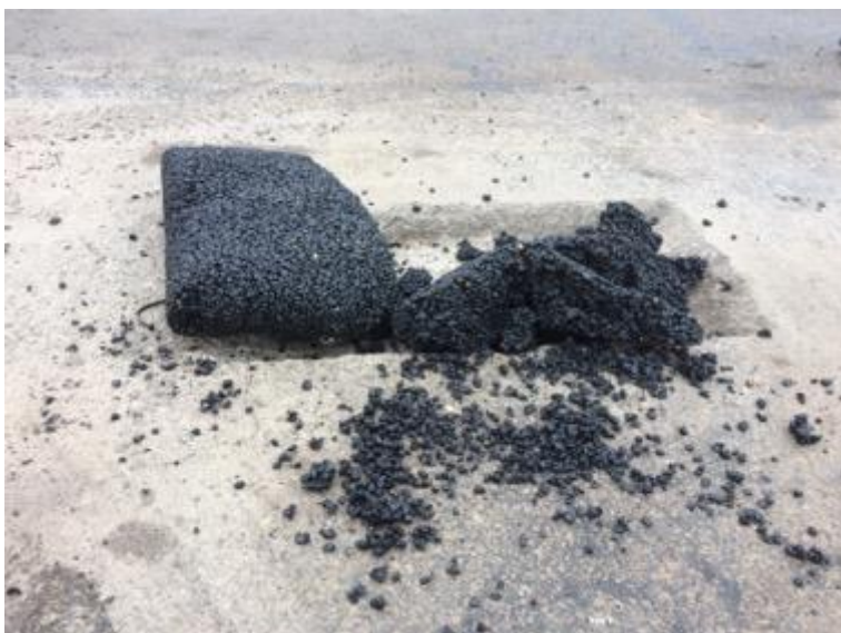
7-6 . attēls. Aukstā bituminētā maisījuma iepildīšana bedrītē
