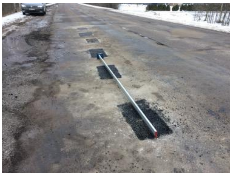
7-15 . attēls. Remontēto bedrīšu līdzenuma uzmērīšana
