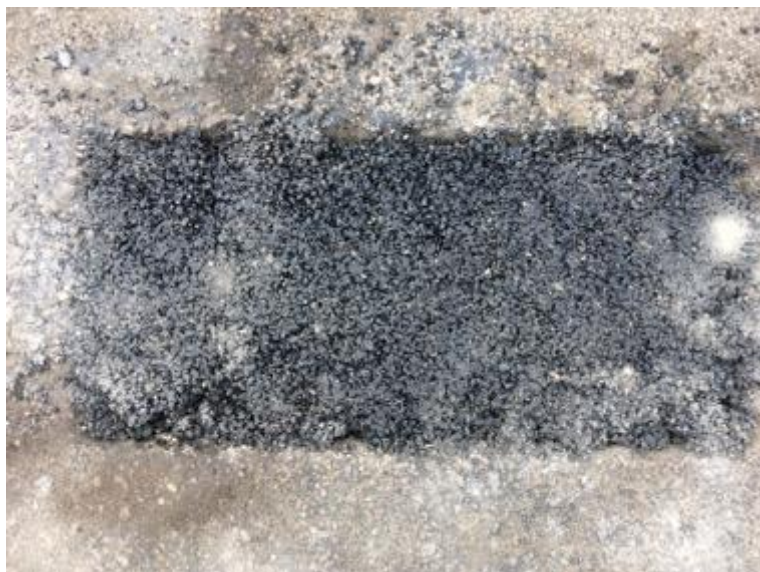
7-22 . attēls. BITUMAX sablīvēts
