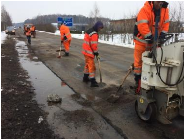
7-4 . attēls. Bedrītes mākslīga radīšana – izfrēzēšana un iztīrīšana
