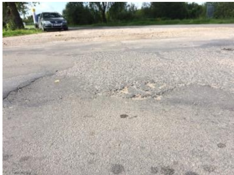
6-14 . attēls. Ar "Smart Asphalt" remontētās bedrītes
