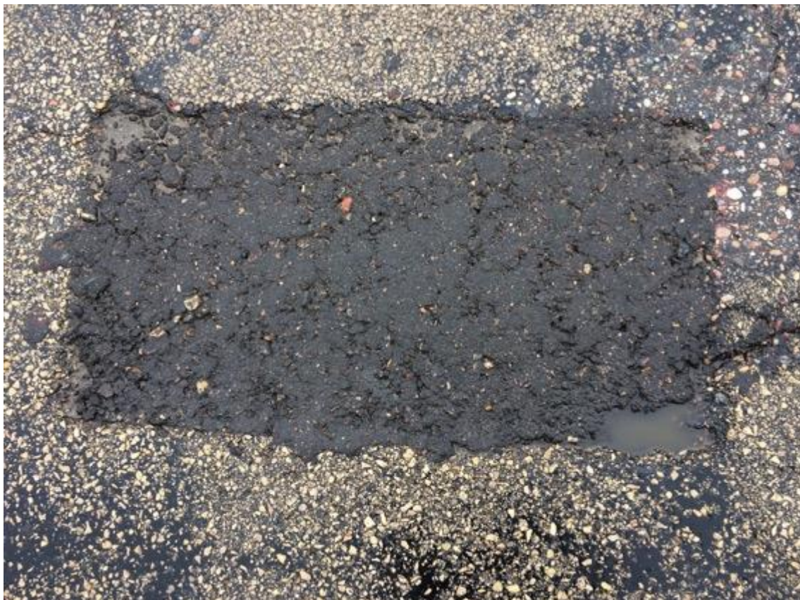
7-38 . attēls. SMART ASFALT 21.04.2017.
