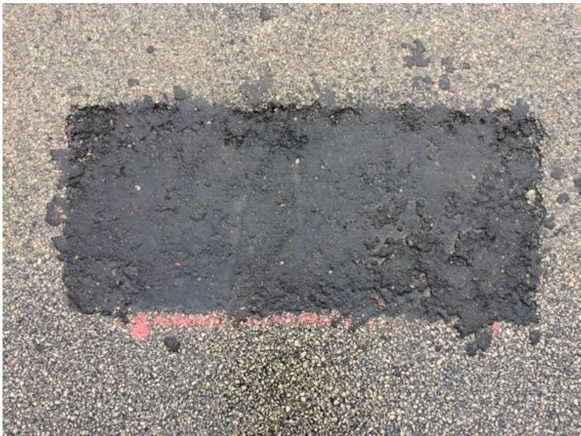
7-31 . attēls. SMART ASFALT 21.03.2017.
