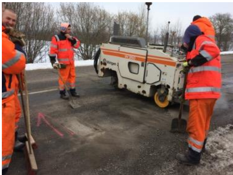
7-10 . attēls. Remontvietu izfrēzēšana šķērsvirzienā
