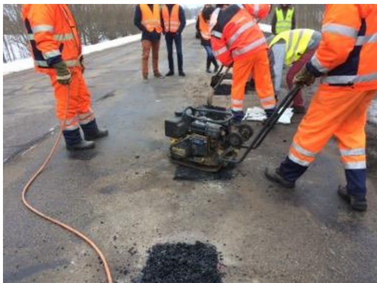
7-9 . attēls. Aukstā bituminētā maisījuma sablīvēšana
