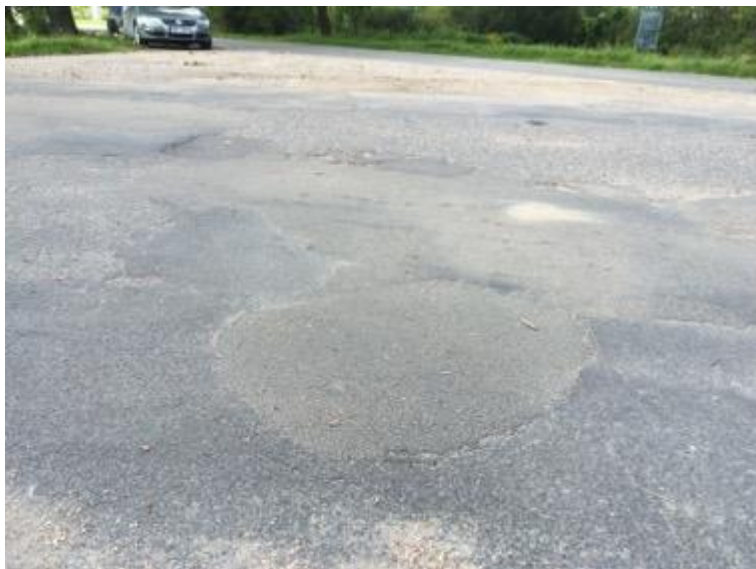
6-15 . attēls. Ar "Bitumax" remontētā bedrīte
