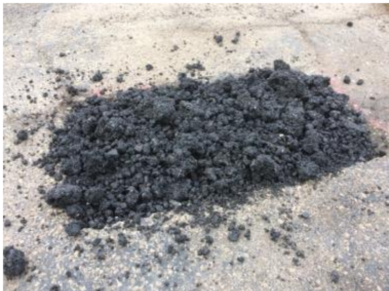
7-18 . attēls. SMART ASFALT pie iestrādes
