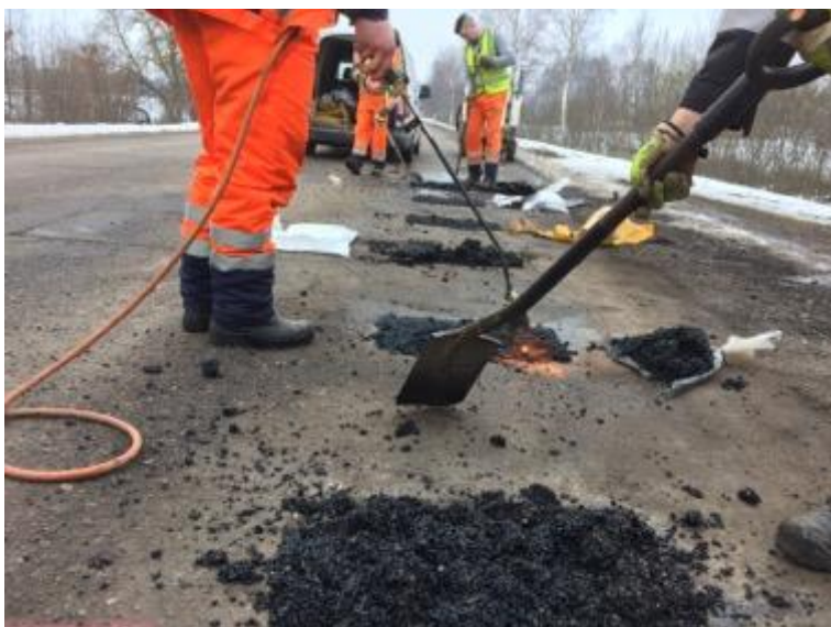
7-7 . attēls. Aukstā bituminētā maisījuma izlīdzināšana
