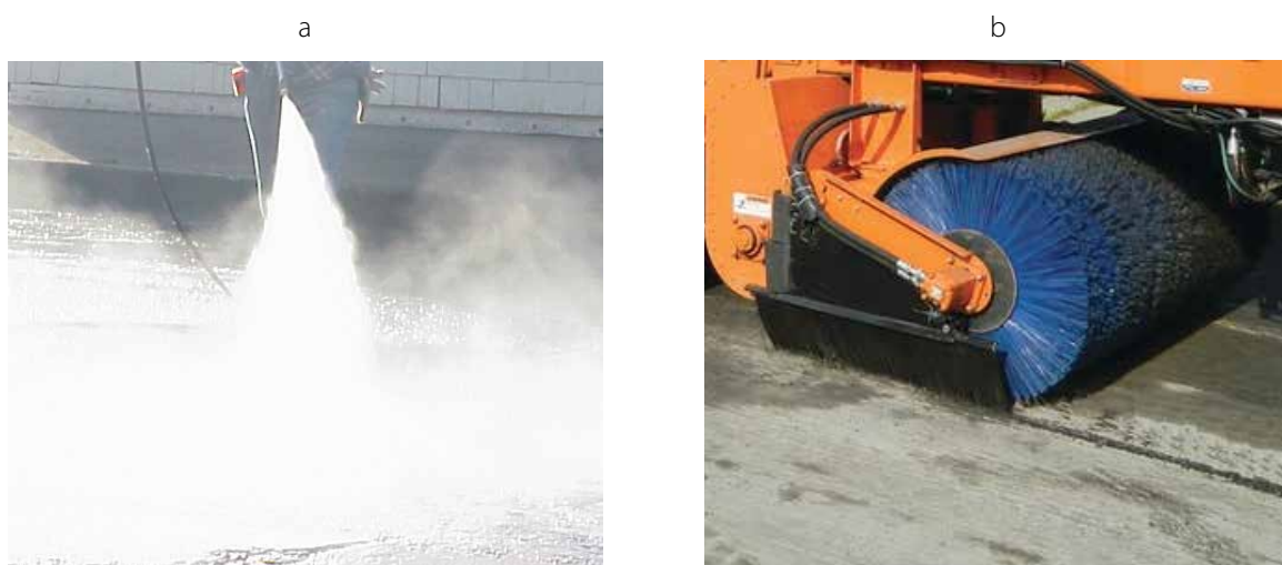
6.4. att. Frēzētas virsmas tīrīšana: a) mazgāšana; b) slaucīšana
