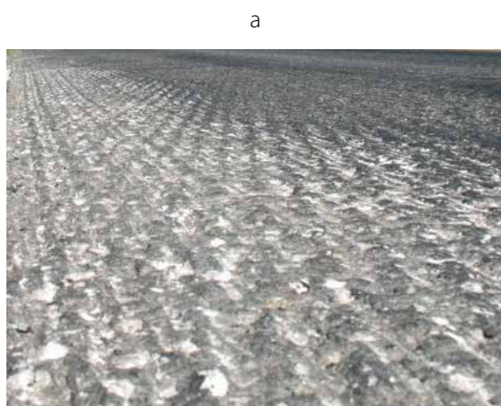
6.2. att. Rupjā (a) un smalki raupjā (b) nofrēzētā seguma tekstūra
