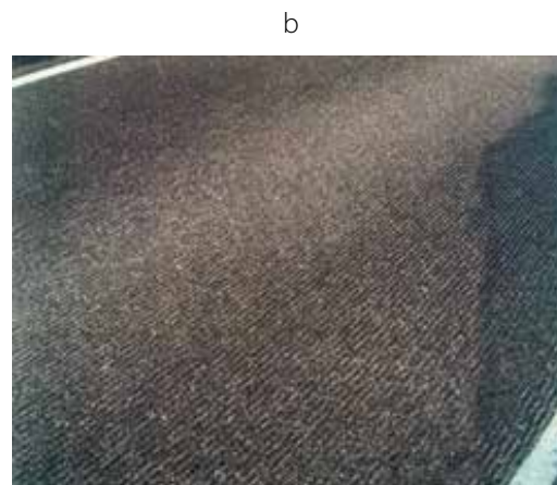
6.2. att. Rupjā (a) un smalki raupjā (b) nofrēzētā seguma tekstūra
