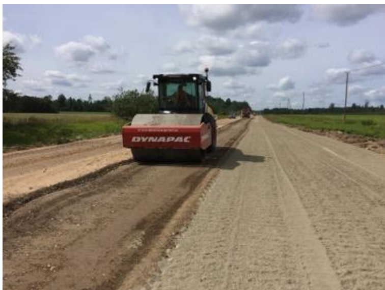
3-26. attēls. Reciklētās kārtas pieblīvēšana
