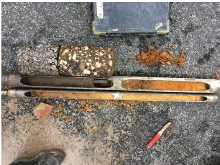
2-5. attēls. Iegūtie paraugi no zemes klātnes un ceļa segas konstruktīvajām kārtām
