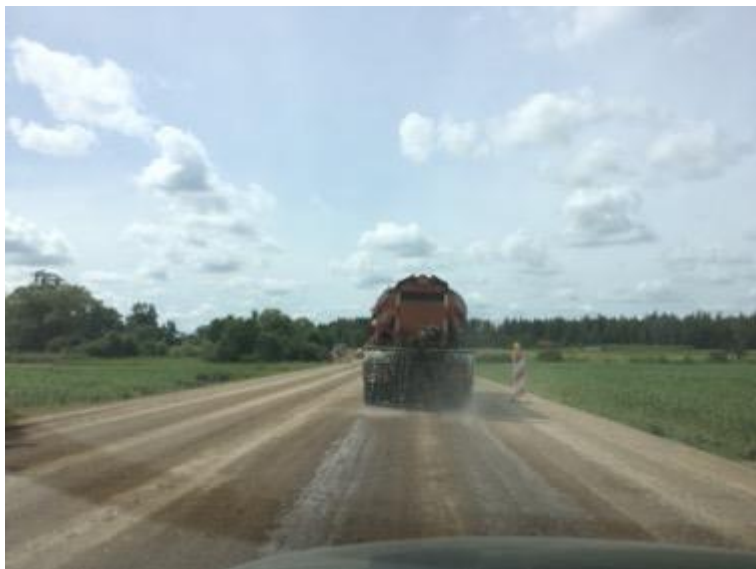
3-27. attēls. Uzbūvētās recikla kārtas laistīšana
