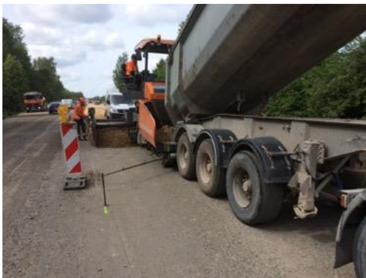
3-20. attēls. Papildus jauna materiāla pievešana un ieklāšana
