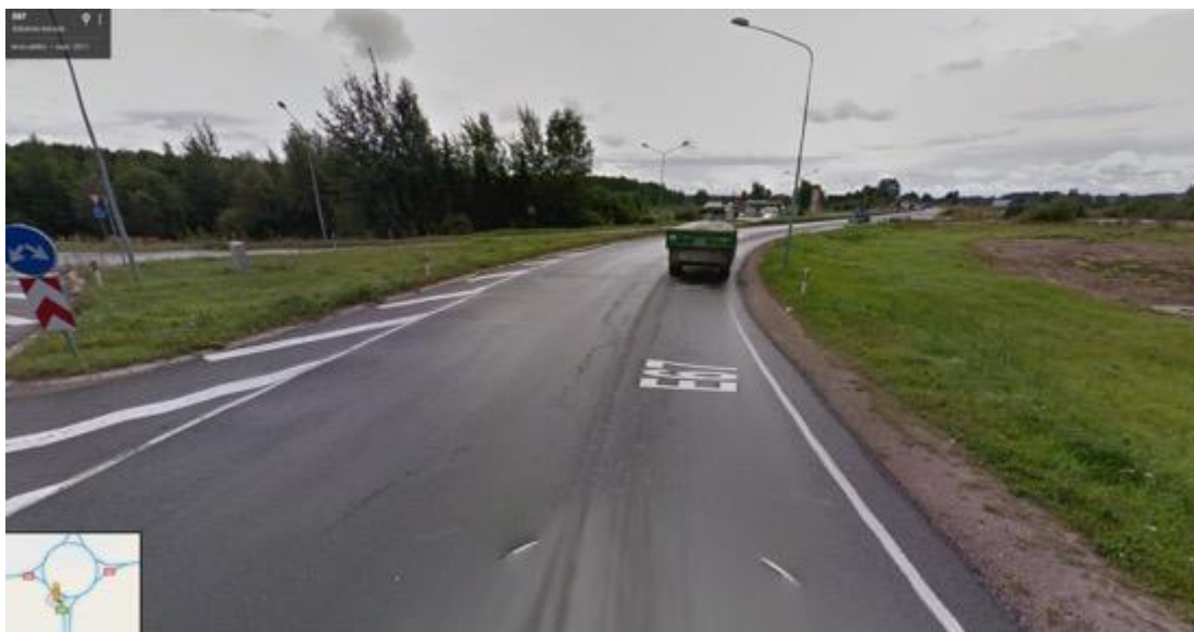
2-46. attēls. Situācija pirms pārbūves a/c A7 19,5 km
