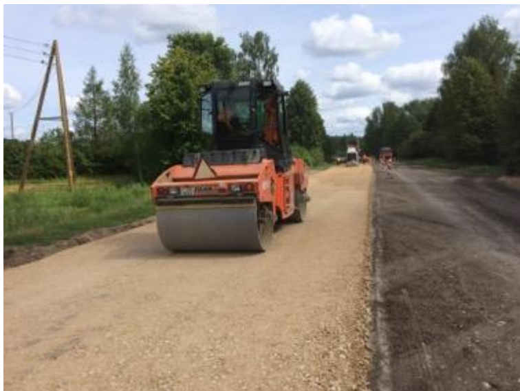
3-21. attēls. Ieklātā materiāla sablīvēšana
