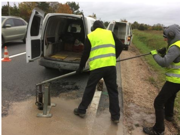
2-4. attēls. Paraugu ņemšanas caurules izvilšana
