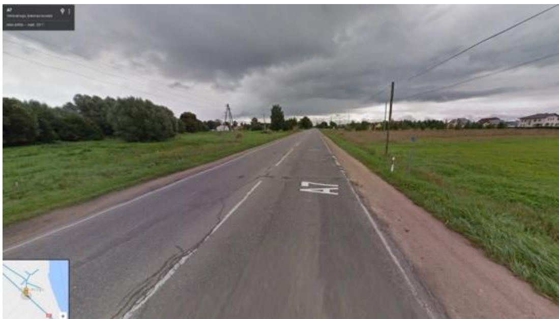
2-44. attēls. Situācija pirms pārbūves a/c A7 16,0 km
