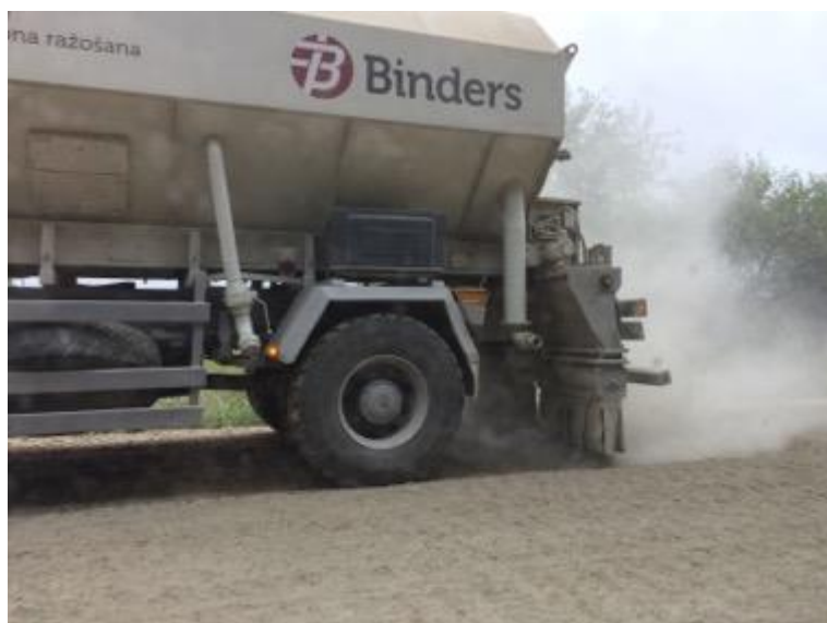
3-22. attēls. Cementa izbēršana ar cementa kaisītāju
