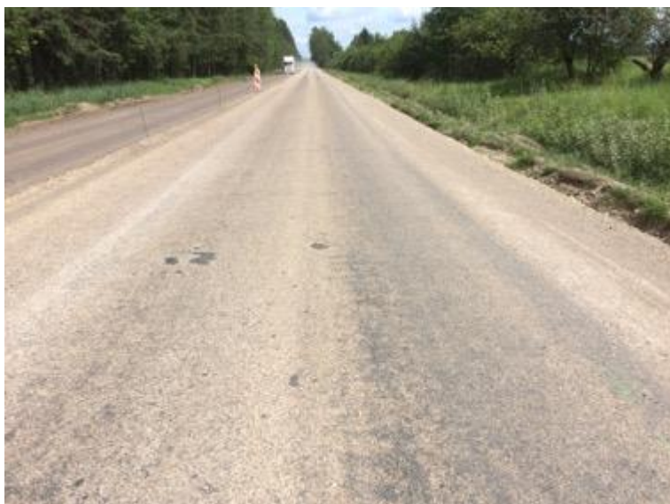
3-28. attēls. Ar bitumena emulsiju un sīkšķembām izolēta reciklētā kārtā
