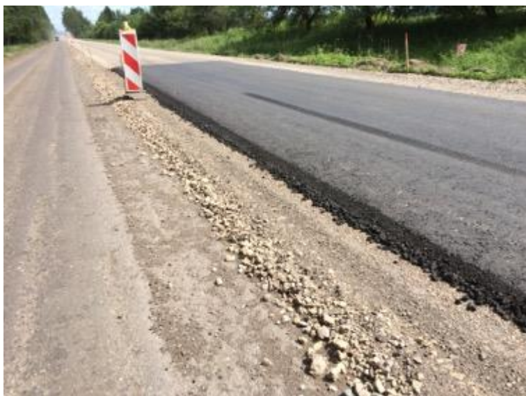
3-29. attēls. Ieklāta karstā asfalta apakškārta virs ar cementu saistītās reciklētās kārtas
