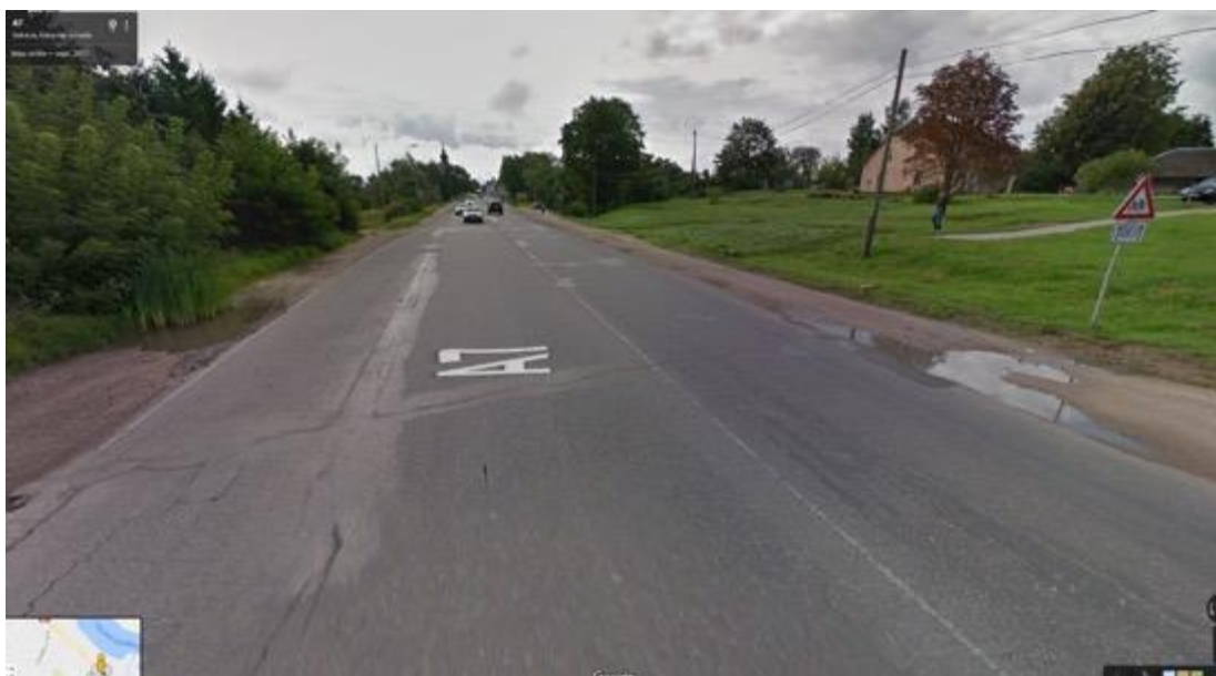
2-45. attēls. Situācija pirms pārbūves a/c A7 17,1 km
