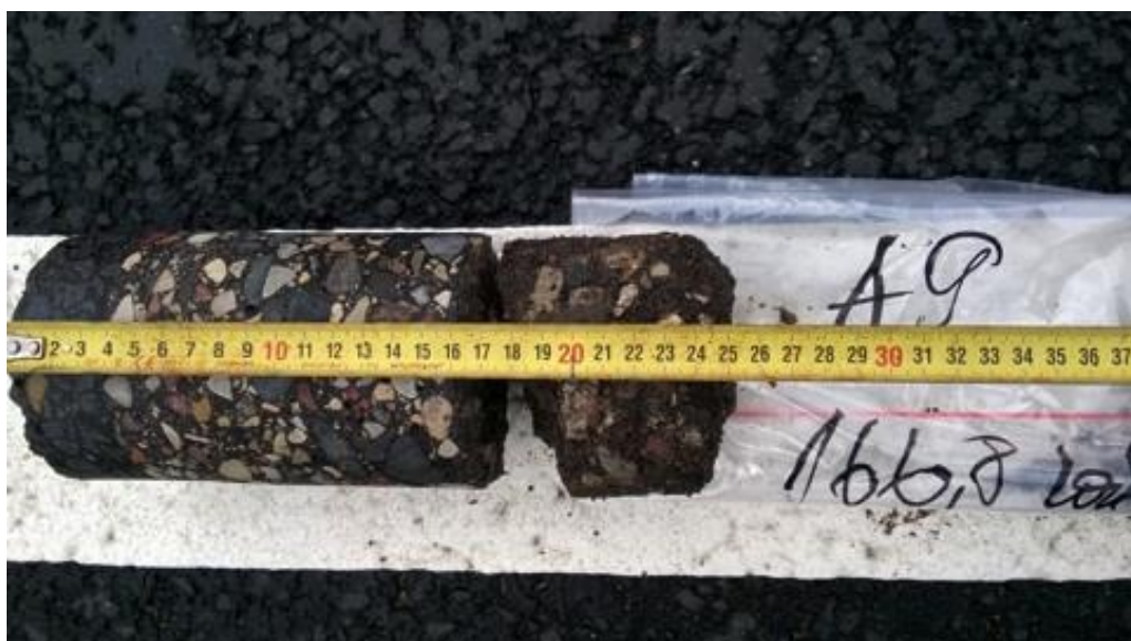
8-8 attēls. Izurbtais asfalta un reciklētās kārtas paraugs 166,8 km
