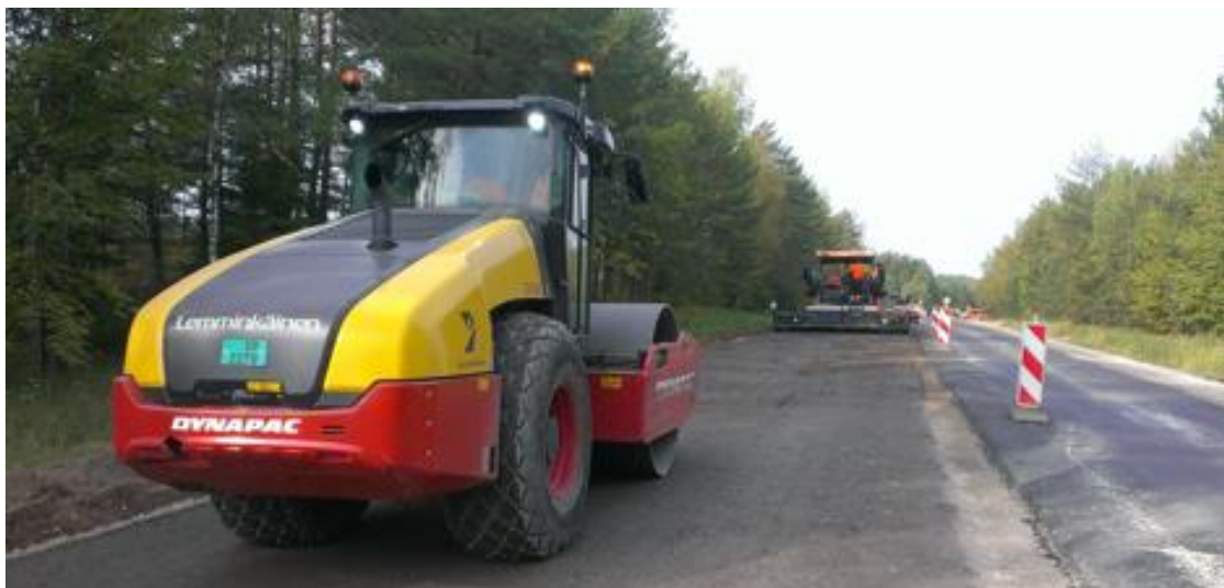
6-15 attēls. Augšējās kārtas sablīvēšana
