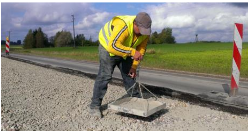
6-8 attēls. Izbērtā cementa daudzuma kontrole
