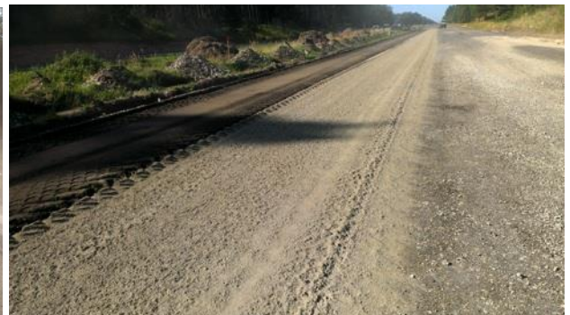
6-2 attēls. Cementa izbēršana.
