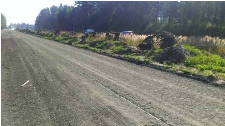
6-1 attēls. Sagatavota reciklējamās kārtas virsma.
