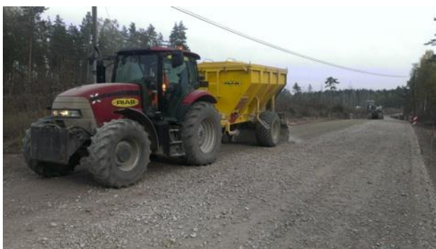
6-16 attēls. Cementa izbēršana
