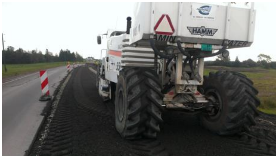
6-9 attēls. Materiāla kārtu samaisīšana un cementa iemaisīšana ar recikleru
