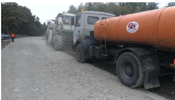
6-17 attēls. Reciklēšana ar ūdens pievienošanu un pieblīvēšana
