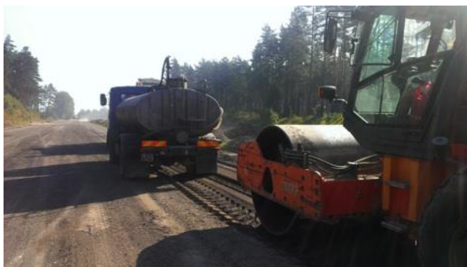
6-4 attēls. Reciklētā maisījuma pieblīvēšana.
