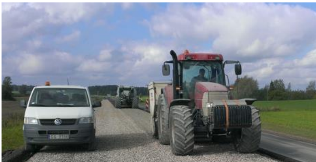
6-7 attēls. Cementa izbērsana ar cementa kaisītāju
