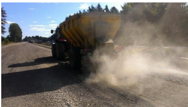
6-2 attēls. Cementa izbēršana.
