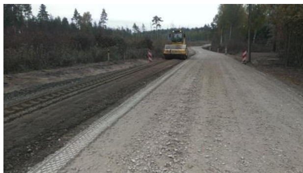
6-17 attēls. Reciklēšana ar ūdens pievienošanu un pieblīvēšana
