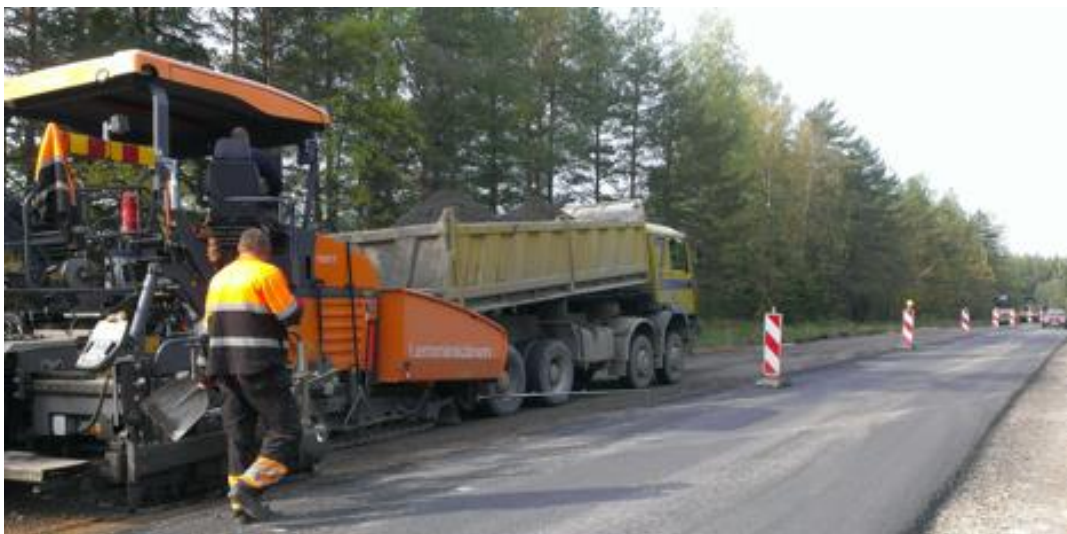
6-14 attēls. Augšējās kārtas ieklāšana ar ieklājēju
