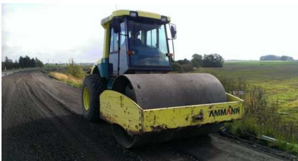
6-11 attēls. Reciklētās kārtas blīvēšana
