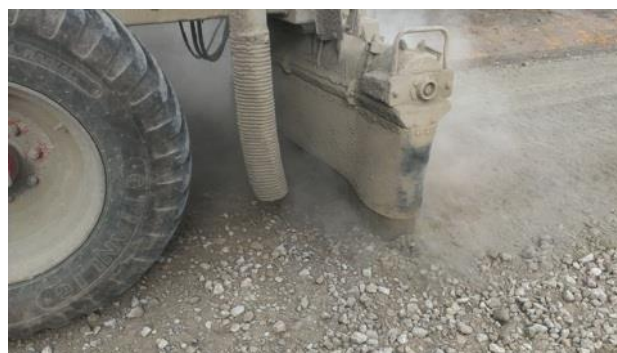
6-16 attēls. Cementa izbēršana
