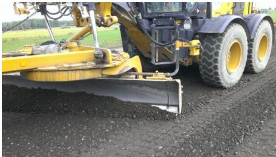
6-10 attēls. Reciklētās kārtas profilēšana ar autogreideri
