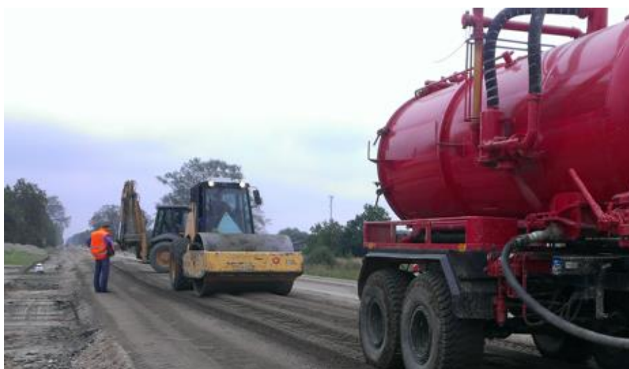
6-6 attēls. Samaisītās kārtas nekavējoša pieblīvēšana ar veltni
