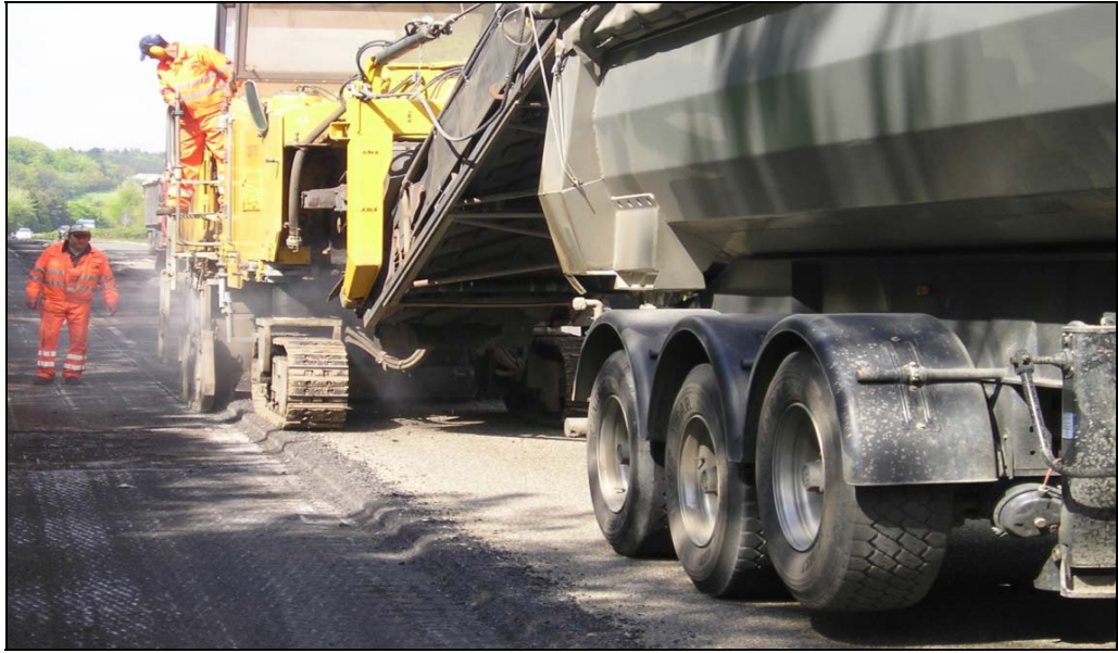
2. att. Asfaltbetona seguma atgūšana frēzējot [15]
