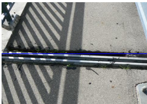
9.24-1 attēls. Blīvējuma šuve starp apmali un segumu, un starp segumu un deformācijas šuvi un mastikas (asfalta) šuve.
