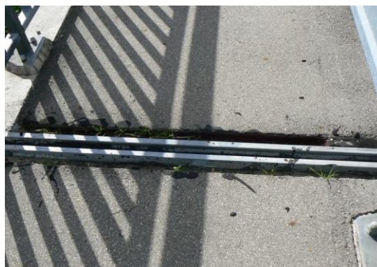
9.24-1 attēls. Blīvējuma šuve starp apmali un segumu, un starp segumu un deformācijas šuvi.
