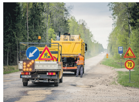
Remontdarbu laikā tiek uzstādīta zīme “Ātruma ierobežojums 70 km/h” uz vismaz vienu diennakti, un remonta posmu apzīmē ar ceļa zīmi “Uzbērtā grants vai šķembas”. Pirms ātruma ierobežojuma noņemšanas brīvās šķembas no autoceļa tiek noslaucītas
