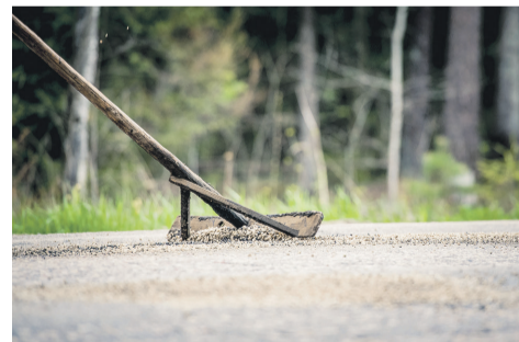
Noslēdzošā šķembu kārtā tiek izlīdzināta
