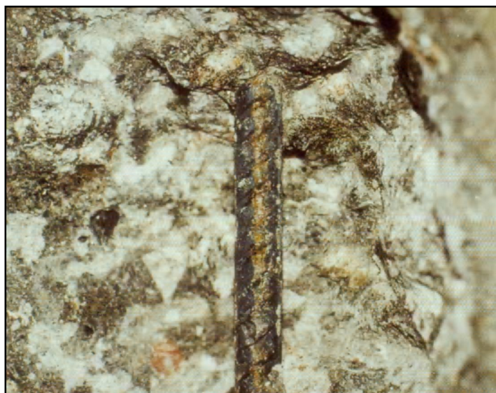
7.3.-14. att. B pakāpes korozijas piemērs
