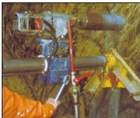
7.3.-8. att. Betona serdeņa izurbšana
