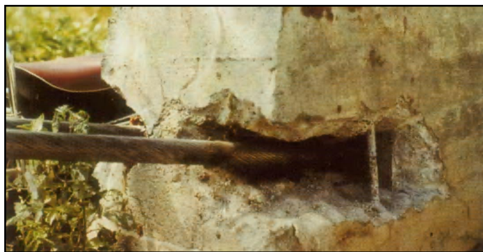
6.5.-1. att. Iebetonēts kabeļa enkurs
