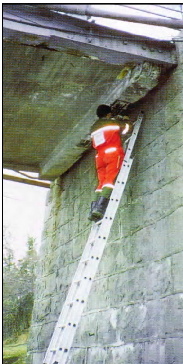
4.2.-1. att. Inspekcija no kāpnēm.
