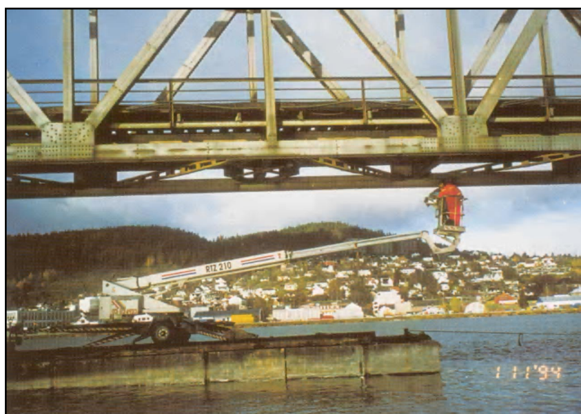
4.2.-2. att. Groza pacelājs uz pontona.
