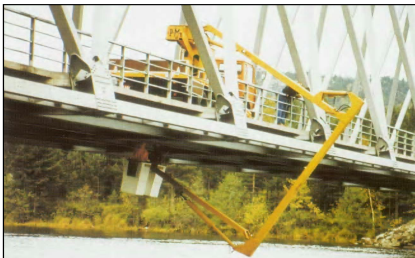
4.2.-12. att. Kopņu tilta inspekcija.
