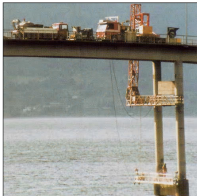
4.2.-14.a att. Augstu balstu inspekcija.
