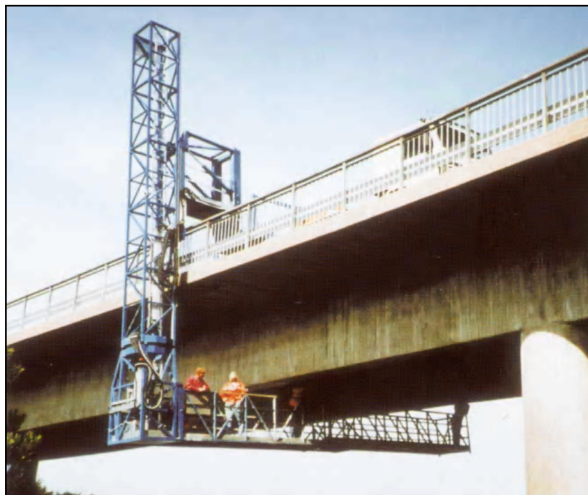
4.2.-9. att. Tilta apskates mašīna ar platformu.
