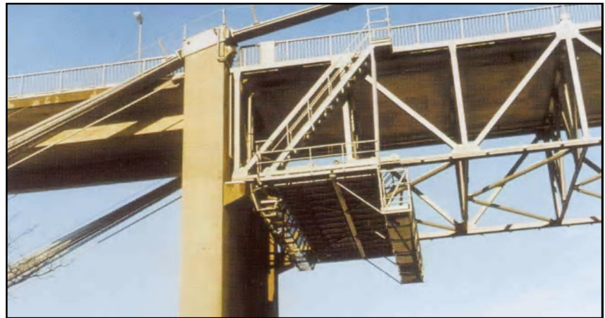
4.2.-15. att. Inspekcija no uzturēšanas ratiņiem.
