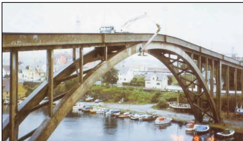
4.2.-11. att. Loka tilta inspekcija.
