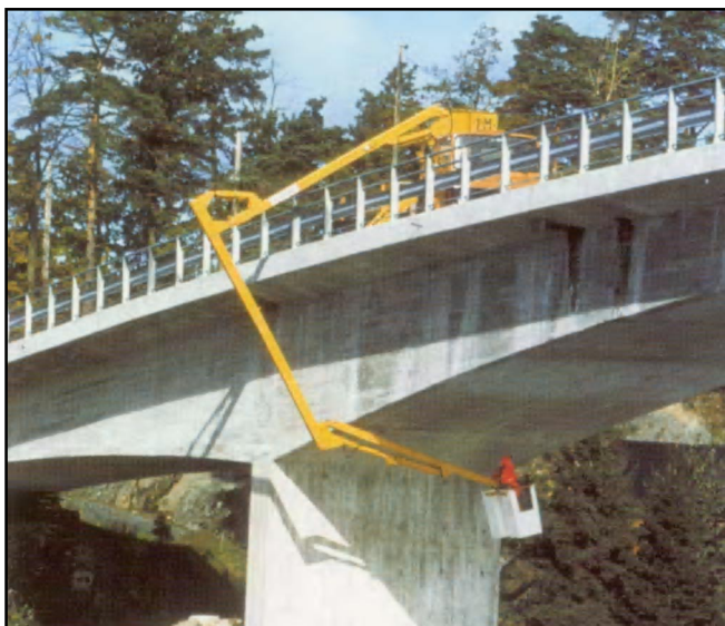
4.2.-10. att. Konsolsijas tilta inspekcija.
