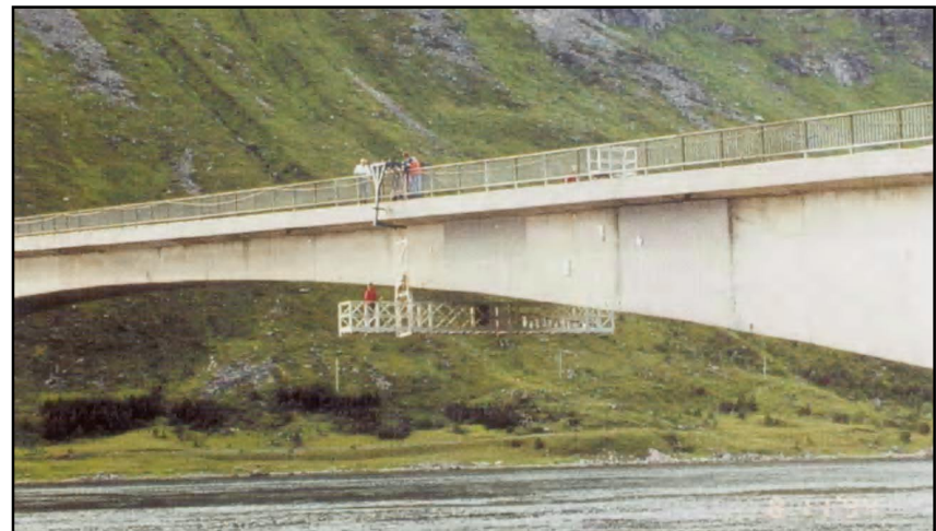
4.2.-16. att. Inspekcija no darba platformas.
